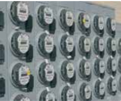
شکل ۳-۲۳- کنتور برق برای اندازه‌گیری انرژی الکتریکی مصرفی به کار می‌رود.
